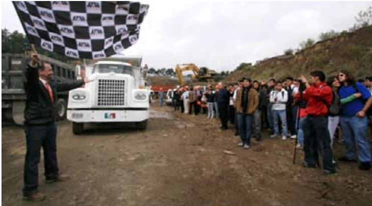
Arturo Rojo Domínguez dio el banderazo de inicio de los trabajos de construcción de la sede definitiva de la Unidad Cuajimalpa. Foto: Alejandro Juárez Gallardo.
